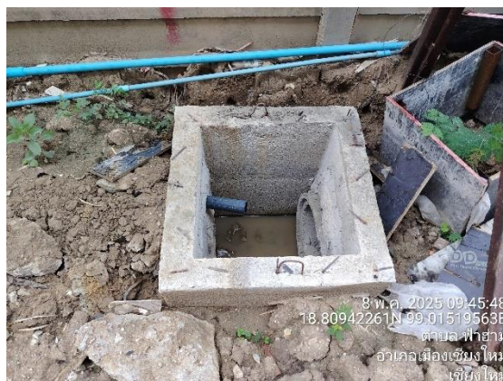
รูปที่ 2-17 การสร้างรางระบายน้ำ และระบบบำบัดน้ำเสีย
