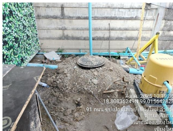
รูปที่ 2-8 ห้องสุขาภายในพื้นที่โครงการ การติดตั้งถังบำบัดสำเร็จรูป
